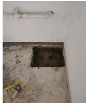
Neu hergestellte Pumpengrube mit Wasserpegel.
