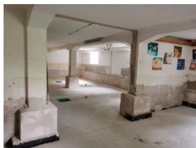
Von links nach rechts: neue Bodenplatte mit Abdichtung (schwarz) und Lüftungsleitungen (für Entfeuchtung) / Dämmschüttung / Heizestrich
