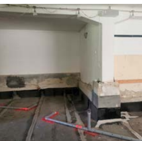
Von links nach rechts: neue Bodenplatte mit Abdichtung (schwarz) und Lüftungsleitungen (für Entfeuchtung) / Dämmschüttung / Heizestrich
