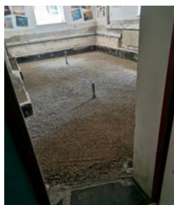
Von links nach rechts: neue Bodenplatte mit Abdichtung (schwarz) und Lüftungsleitungen (für Entfeuchtung) / Dämmschüttung / Heizestrich
